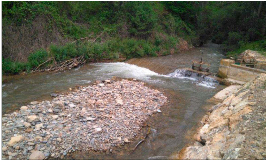
Presa Queiles II. HDS
