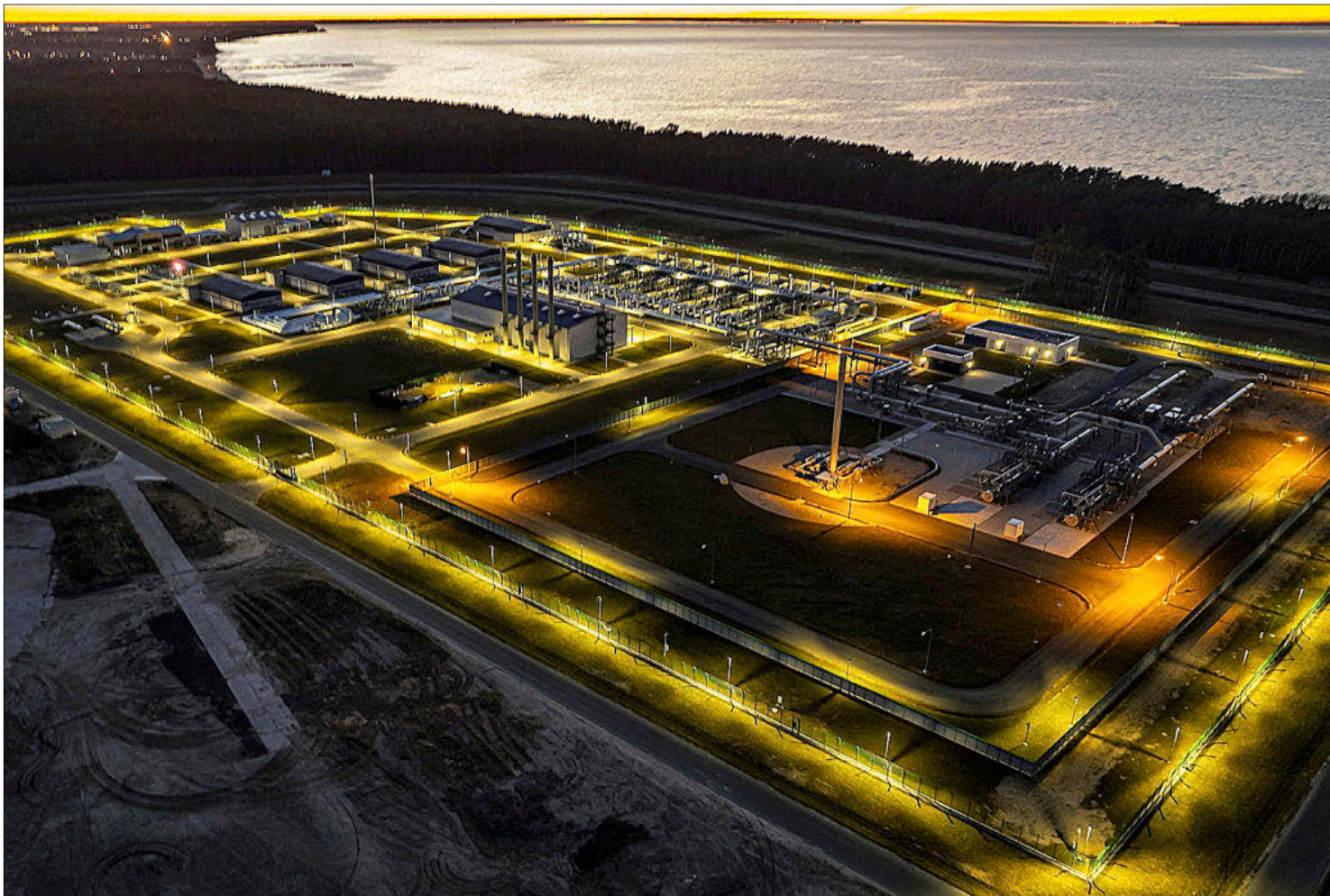
Tuberías en las instalaciones de aterrizaje del gasoducto Nord Stream 2 a su paso por Lubmin, Alemania. HANNIBAL HANSCHKE / REUTERS
